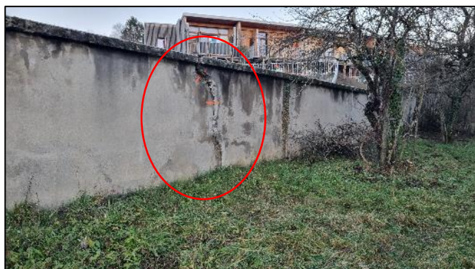
Photographie de la fissure de séparation
