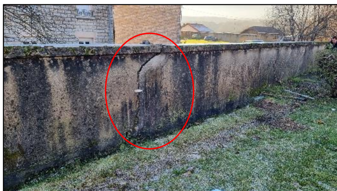
Photographie de la fissure de séparation
